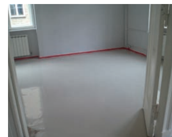
Berliner Altbau: So sah der Trarpalast vor den ersten Bauarbeiten aus.
